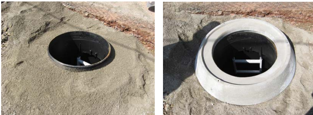
Slika 9 i 10: Postavljanje betonskog prstena za prihvat opterećenja
