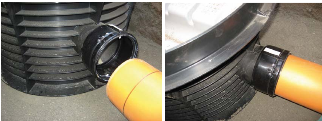
Slika 5 i 6: Izvođenje spoja šahta sa PVC cijevima
